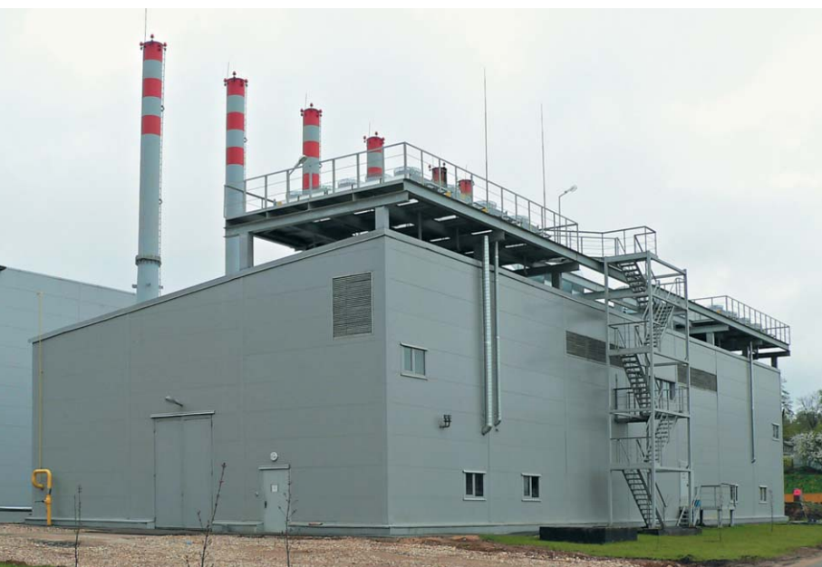
ТЭС мощностью 7,3 МВт размещена в легкосборном здании
