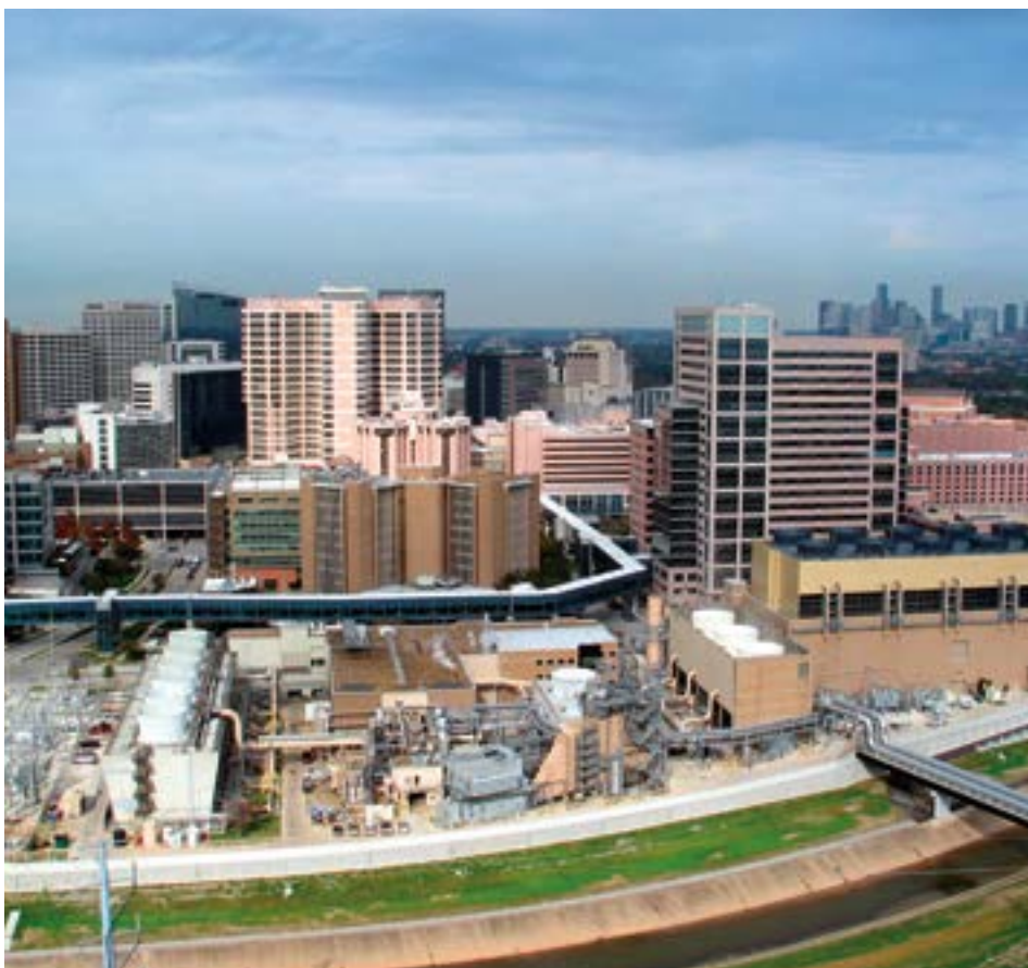
Thermal Energy Corporation (TECO) в Техасском медицинском центре, Хьюстон
